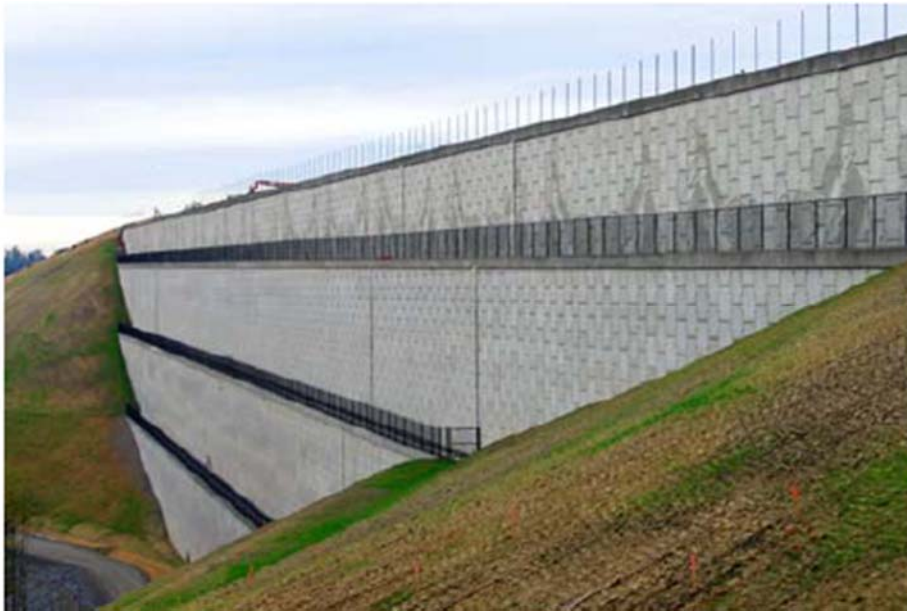
Sea Tac Airport. MSE Wall de 42 m de altura. Tomada de FHWA GEC 011 (2009)
